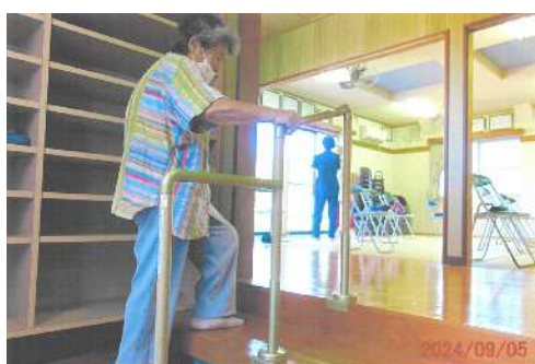
野中村・横須公民館 (手すり設置)
